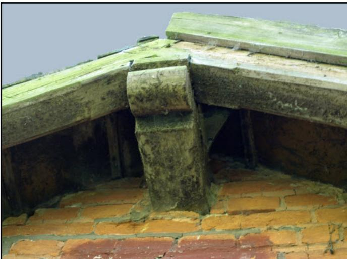
Beim Südbahnposten 99 (hier die Vorbildaufnahme) liegt der Freisparren direkt an der Außenkante. Die Windfeder ist direkt an dem Freisparren montiert.
