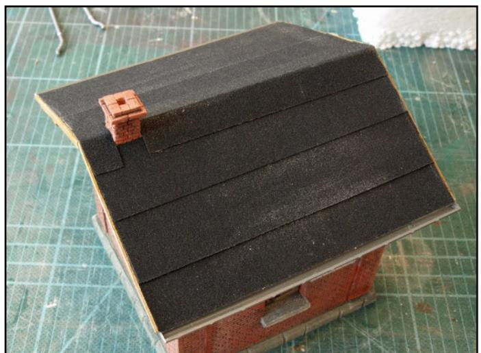
Die Firstbahn sollte vorher einmal mittig längsgefaltet werden. Die Bahnen sollten ruhig länger sein, als die Dachbreite und können dann mit einem Nagelschrecken gut abgelängt werden.
