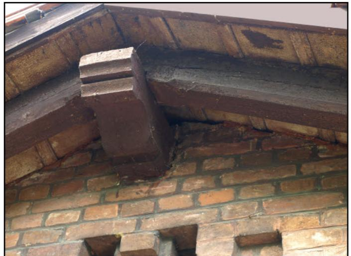
Beim Posten 110 (Vorbildaufnahme) liegt der Freisparren weiter innen - die Windfeder ist an der überkragenden Traufschalung befestigt.
